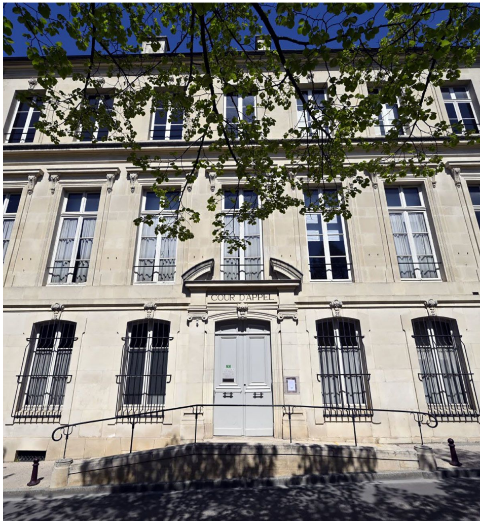
Le bâtiment de la Cour d'appel de Nancy.
